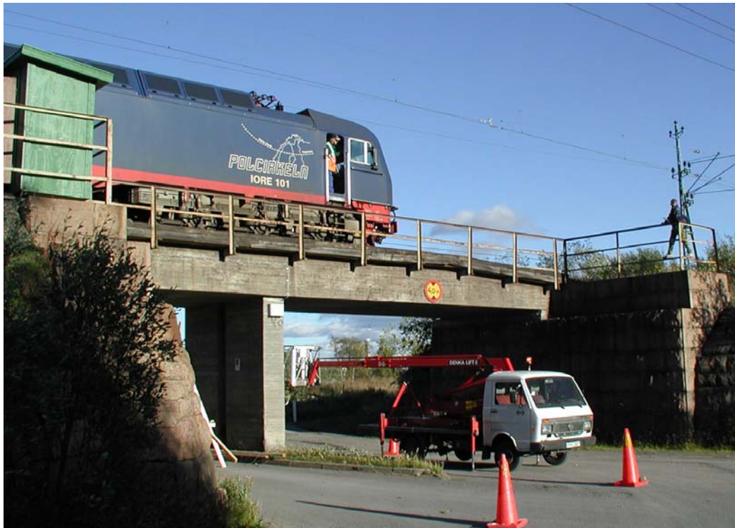
Figur 7.3. Luossajokkbron under last. IORE loket står placerat enligt värsta tänkbara scenario vilket ger maximala töjningar i det kritiska snittet. Simonsson (2002)
